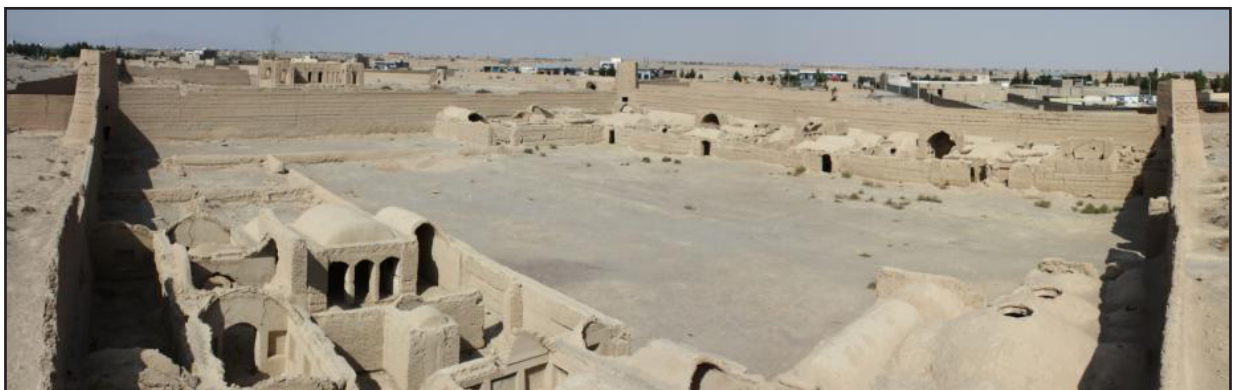
تصویر ۱۱. تصویر کشیده‌شده از قلعه عزت آباد (مأخذ: پرونده ثبت اثر).
